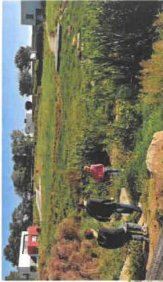
Bassin tampon rendu accessible par des enrochements
