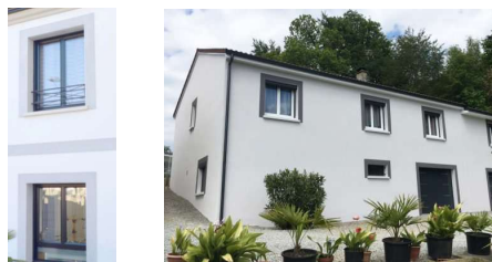
Exemple de modénatures en enduit
