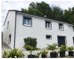
Exemple de modénatures en enduit
